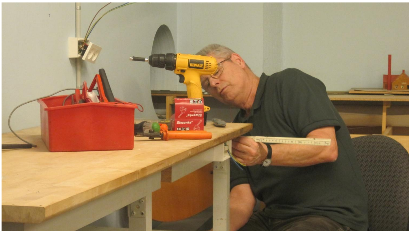
Onsdag d. 12.12. Så er Bent ved at lægge den "sidste hånd" på de elektriske installationer i rum 5. Alle arbejdsborde har fået flere stik til diverse formål – nu mangler bare den individuelle arbejdsbelysning, ved bordene.
