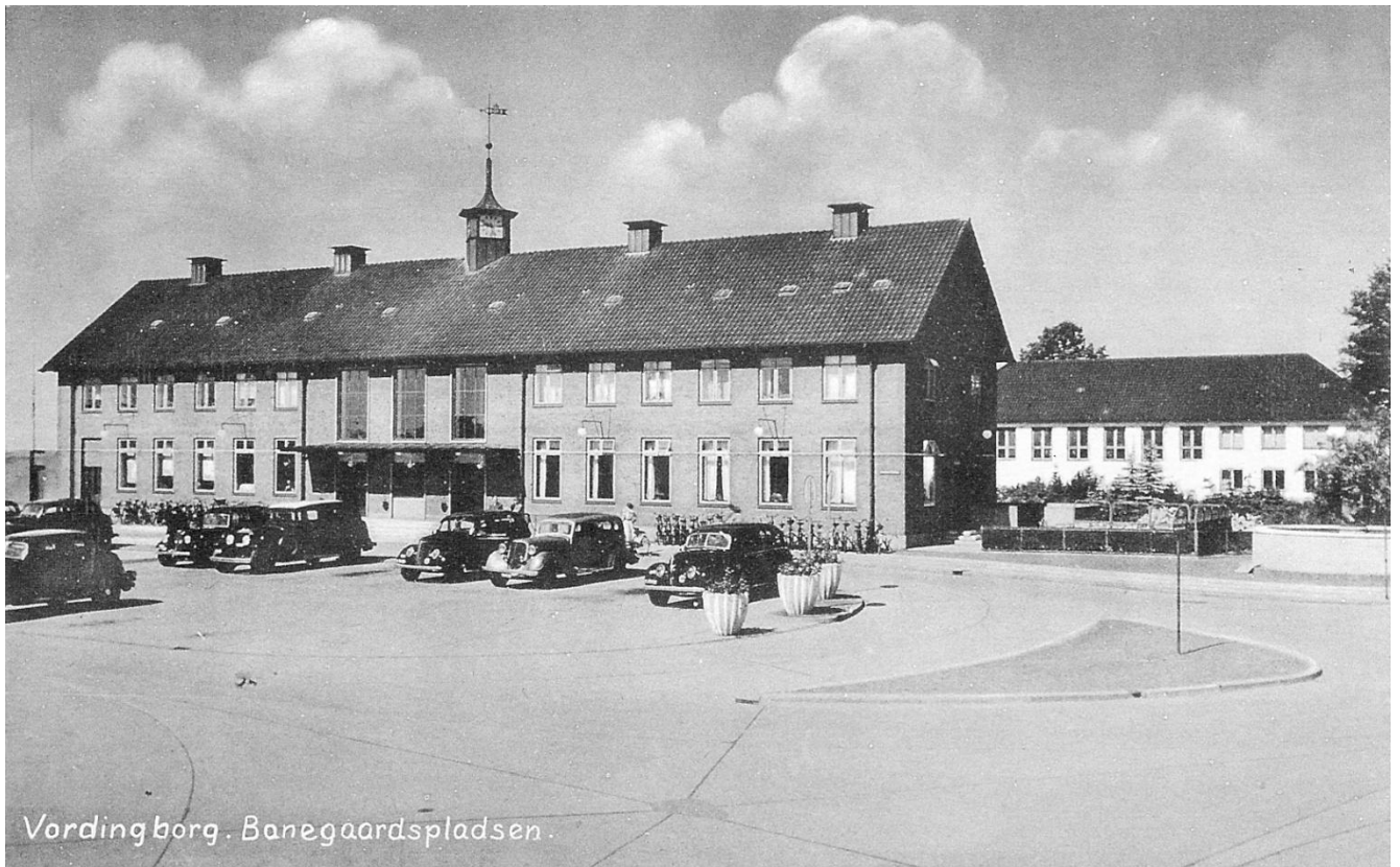
Vordingborg Station, forbillede for vores "Sukkerkøbing", Jørgen er i gang med bygningen af stationsbygningen. Postkort.
